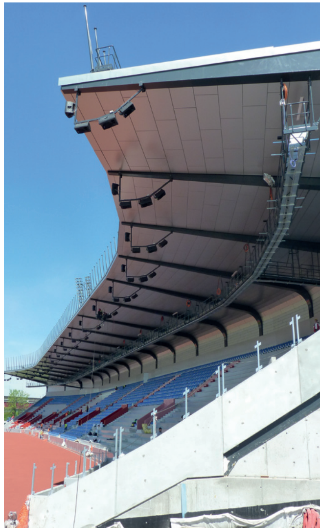
Na sřeše, 1,4 m od konce konzol ráků, je umístěna podélná lávka.
