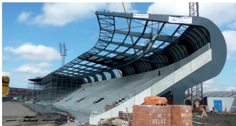
V posledním kroku byla provedena montáž vnějších a vnitřních obloukových mezisloupků.
