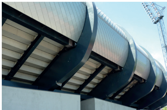
Při zadních koncích rámu jsou upevněny pozinkované trapézové plechy zadní stěny.
