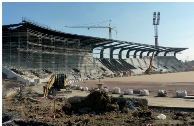
Montáž začala sestavením obslužných lávek na předmontážní ploše.
