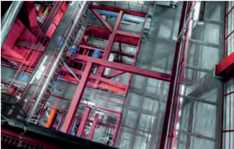
*Zakrytí technologických plošin a lávek*
